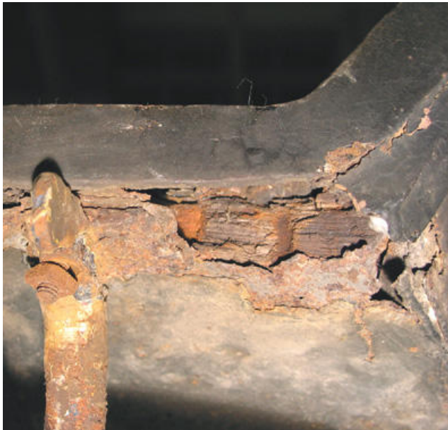
Abb. 82: Die linksseitige Ecke unterhalb der Trittfläche des Kutschbocks ist durchgerostet; Schraubenspuren im beschädigten Holz zeigen zwei frühere Positionen der Vorderachsaufhängung an.
