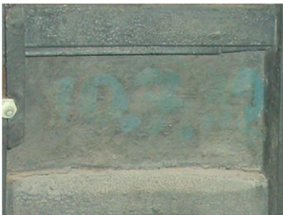
Abb. 30: Rechte Türe, Karosserieblechinnenseite, oberhalb der Querstrebe (vgl. Abb. 36). Deutlich sichtbar die mit dicken Pinselstrichen aufgetragene Datierung „10.7.32“
