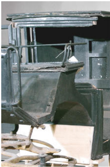
Abb. 69: Abgerissene Fenstersäule und beschädigte Eckverbindungen am übrigen Teil des vorderen Fensterrahmens.
