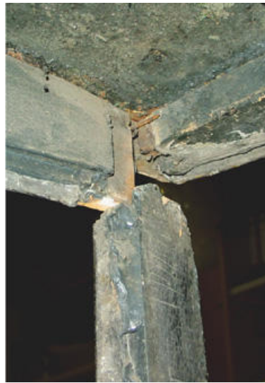
Abb. 70: Stark beschädigte rechte vordere Eckverbindung von Fenstersäule, Rahmenfries und Längsstrebe unterhalb der Dachkante (Sicht von innen).
