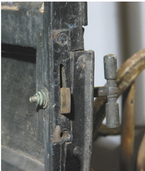
Abb. 48: Türverriegelung (linke Türe). Man erkennt den Türgriff mit Drehriegel, das Schließblech und das entfernt T-förmige, aufgeschraubte Eisenprofil auf der der Türkante.
