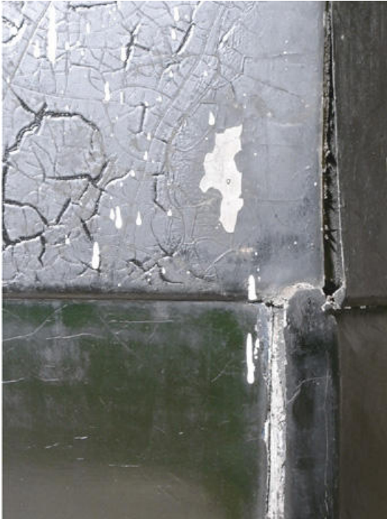
Abb. 84: Aufgerissene Löt Nähte an der Ecke von Rückwand und rechter Seite der Kabine. Die Karosseriebleche haben sich verwölbt.
