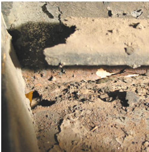
Abb. 67: Die hintere Querstrebe am Wagenboden wurde vor allem am rechten Ende stark von holzabbauenden Pilzen befallen und zeigt hier großen Substanzverlust; auf der Lackierung liegen u.a. festgebackene Lackschollen auf.
