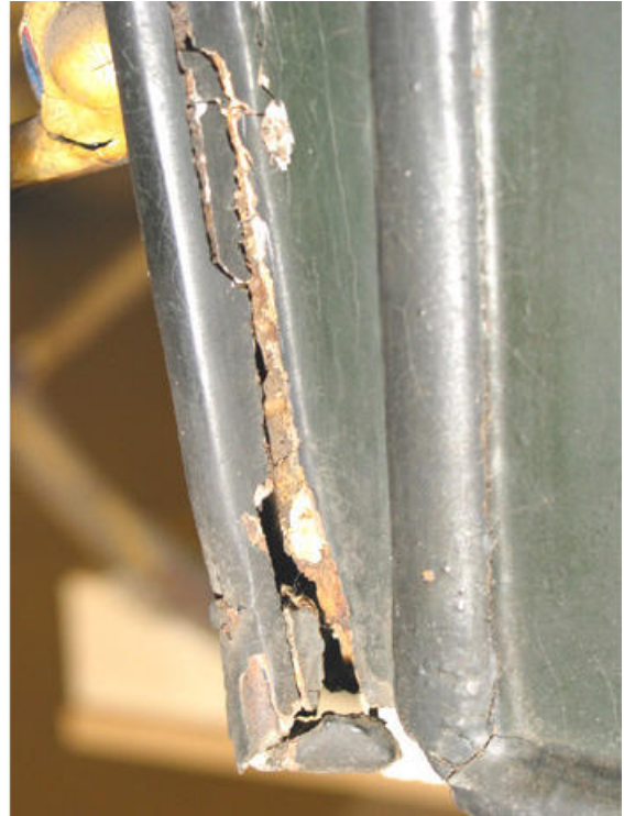
Abb. 85: Rechte Kabinenseite unten, hinter der Türe. Durch Rostunterwanderung ist hier die Lötverbindung zwischen Eisenblech und Messinghalbrundprofilen aufgerissen.
